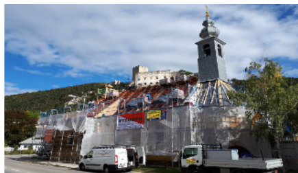
St. Helena während der Dacharbeiten Foto: RUDOLF WESSELY
