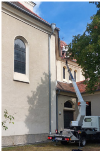
Erneuern der schadhaften Dachrinnen am Kirchendach
