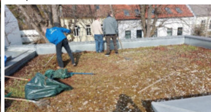
Freiwillige Helfer bei der Reinigung des Flachdaches (Pfarrheim)
