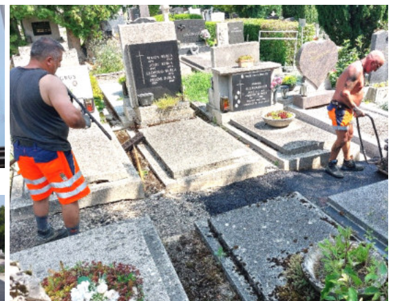
Sanierung von schadhaften Gehwegabschnitten am Helenenfriedhof (oft in aufwendiger Handarbeit)
