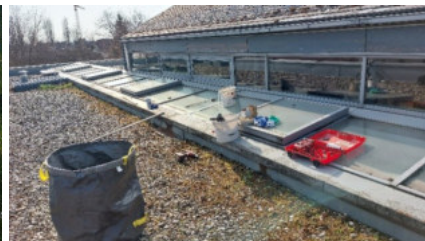
Reparatur Nässeschaden - Pfarrheim
